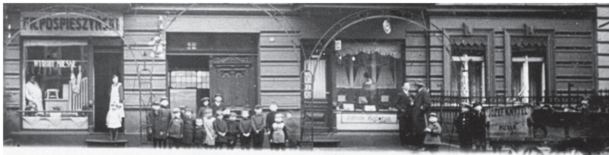
Fot. 6. W oknie sklepu mięsnego stoi pani Maria Pospieszyńska („dzib sklepu”), na schodach mała Anetka ze swoją nianią, na tle bramy dzieci mieszkańców kamienicy, m.in. Trudka, Klara i Wiktor Pakułowic
