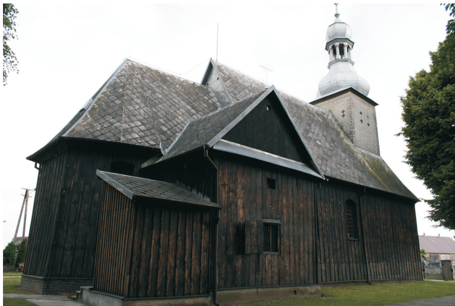
Ryc. 5. Południowa strona kościoła w Starymgradzie z charakterystyczną okiennicą, 2015 rok. Fot. J. Mazur
