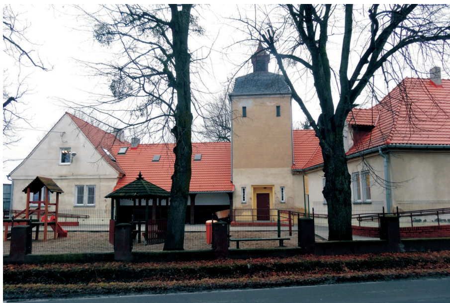
Ryc. 3. Budynek Zespołu Szkół Specjalnych nr 112 w Poznaniu przy ul. Obornickiej 314 – dawniejsza piątkowska szkoła pruska z początku XX wieku. Fot. M. Witaszek, 2015 rok
