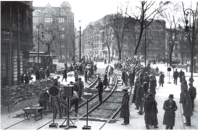
Ryc. 2. Ulica Pocztowa (ob. Lewandowskiej) – lata 30. XX wieku. Trwa budowa nowego torowiska tramwajowego, które przetnie plac Nowomiejski (ob. plac C. Ratajskiego). Zwraca uwagę brak ciężkiego sprzętu budowlanego, większość robót wykonywano po prostu ręcznie. Źródło: D. Książkiewicz-Bartkowiak, J. Skuterki, Miasto z wizją. Poznań w dwudziestoleciu międzywojennym , Poznań 2009, s. 40
